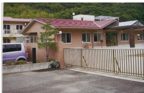
👉 新園舎の正面玄関付近
